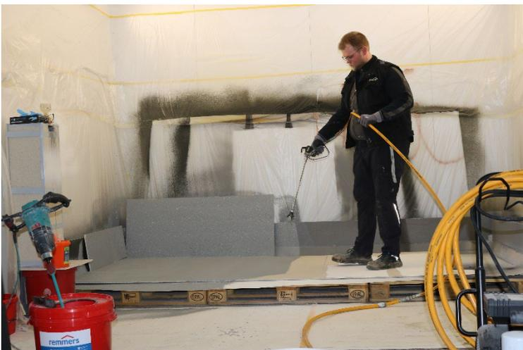
Das aus drei Abdichtungsprodukten bestehende System kann im Spritzverfahren aufgebracht werden – das spart Zeit.
