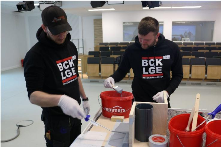
Die teilnehmenden Handwerker können im Rahmen der „Flachdach-Spritztour“ das PU-Hybridssystem MB PUReactive an einem Modell testen.
